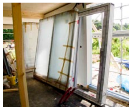
Žiher hiša PRESTIGE: Montaža PVC oken Stabil Design 80
